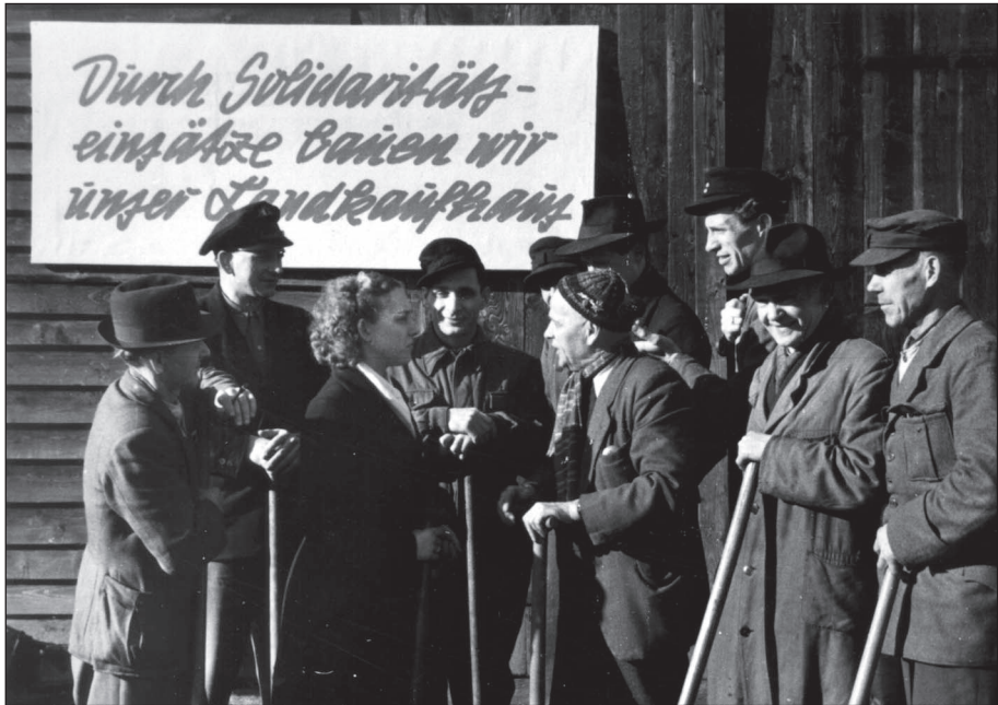
Subbotnik zum Bau des Landwarenhauses in Cambs (Bezirk Schwerin) 1953.
